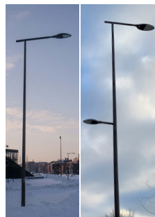
Otaniementien valaisimia Valaisin: Philips MileWide 2. Erikoispylväs, malli: Otaniemi. RAL 7022
