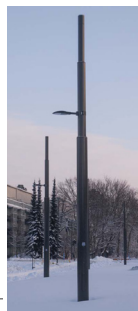
Raidejokerin valaisimia Philips MileWide 2. Pylväs ja varsi: Yhteiskäyttöpylväs, raitiotie RAL 7022
