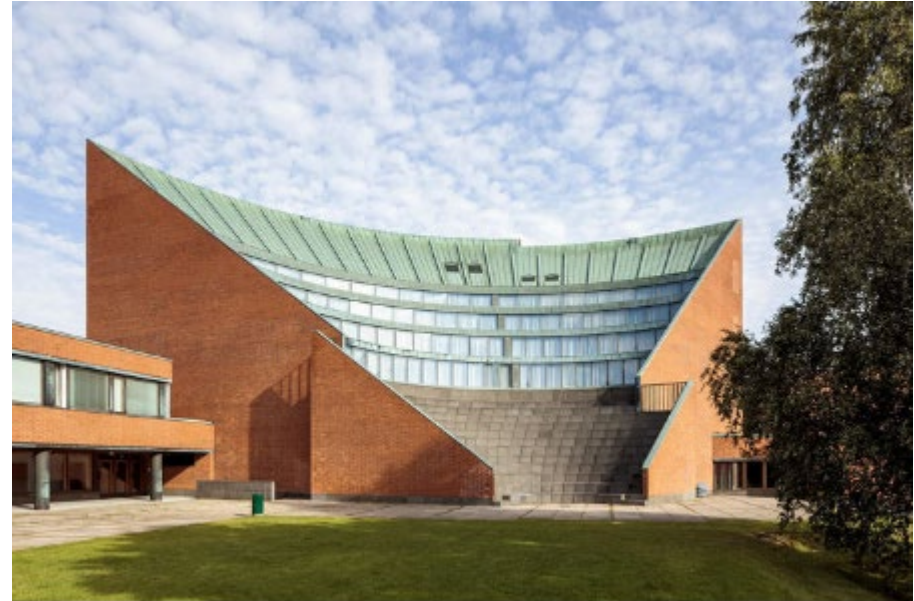
Kandidaattikeskus on kulttuurihistoriallisesti merkittävä suojeltu rakennus kampuksen ytimessä. Myös avoin näkymälinja ns. amfitorniin on suojeltu asemakaavassa.
