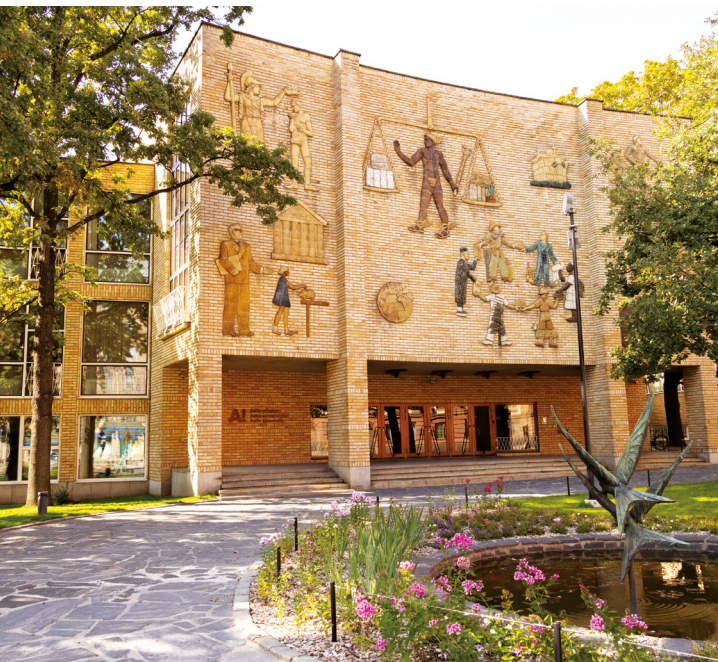
Kuva 24. HKKK:n entinen päärakennus Runeberginkadulla.
