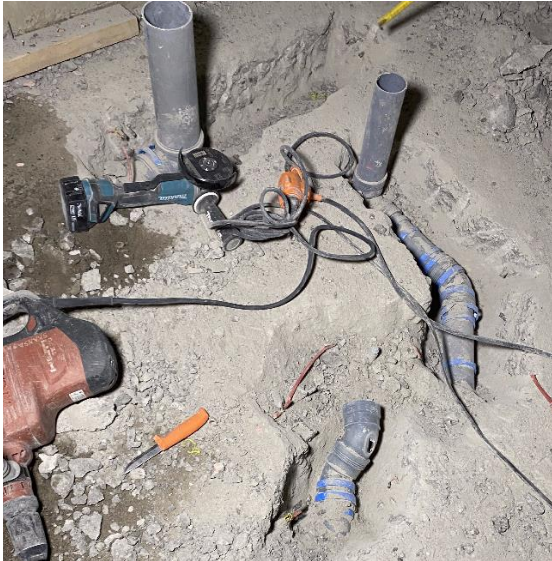
Kuva 6: Viemäriasennuksen uudelleen tekemistä liian myöhään havaitun mittavirheen takia
