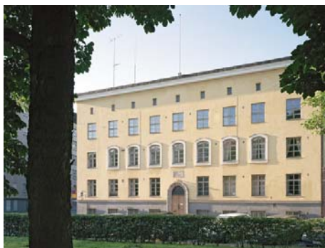
Kiinteistö Oy Helsingin Eteläinen Hesperiankatu 4
