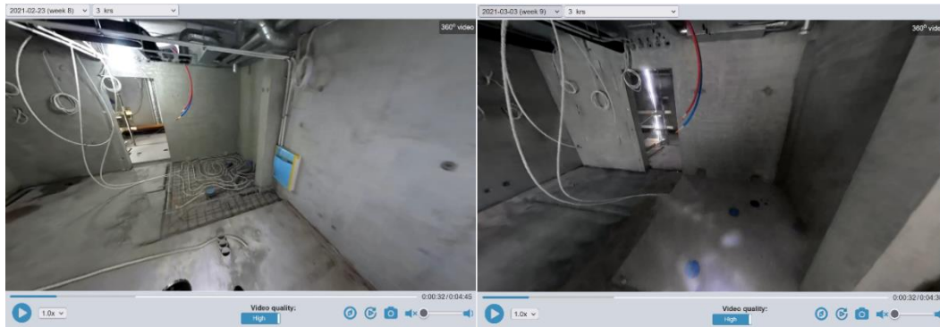
Kuva 9. Valamaton ja valettu kylpyhuoneen lattia
