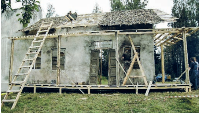
Talo rakenteilla. Muukalainen (2009).
