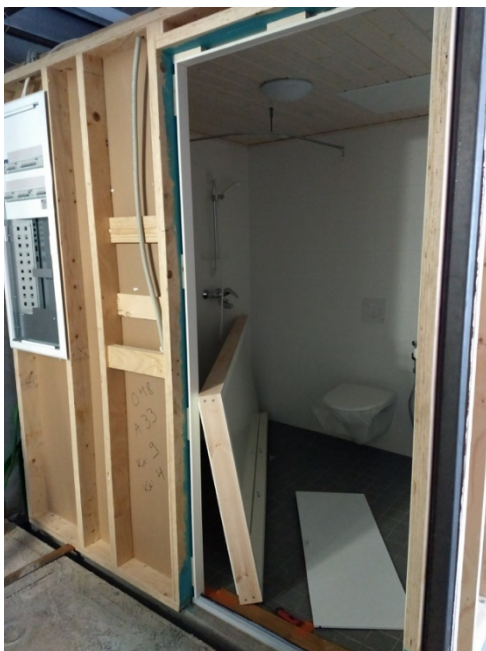
Kuva 2. Kylpyhuonemoduuli, jonka talotekniikka on asennettu tehtaalla valmiiksi.
