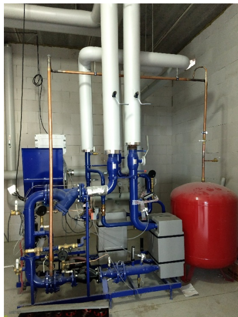
Kuva 3. Lämmönjakokeskus.
